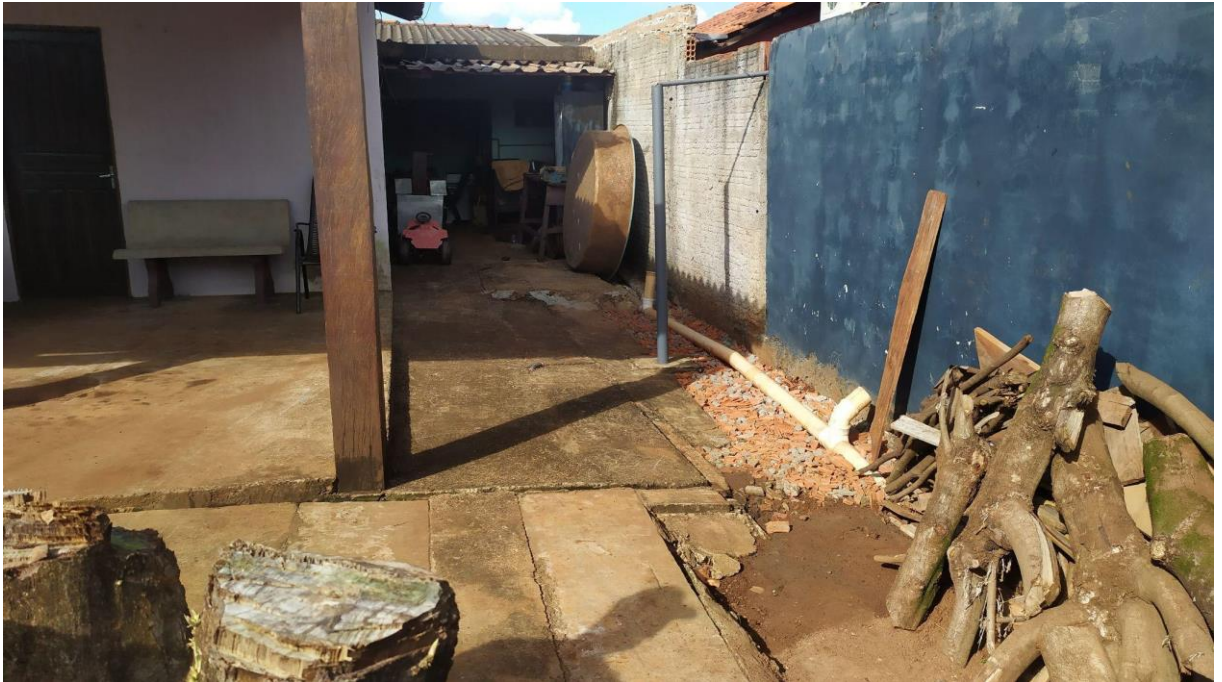
Figura 16 - Vistas em uma moradia no loteamento Jardim Pantanal, rua Colibri.
