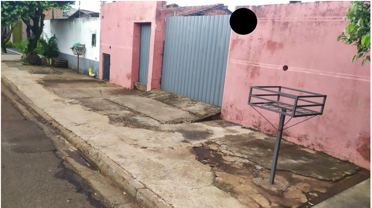
Figura 15 - Vistas da frente de uma moradia no loteamento Jardim Pantanal, rua Colibri.
